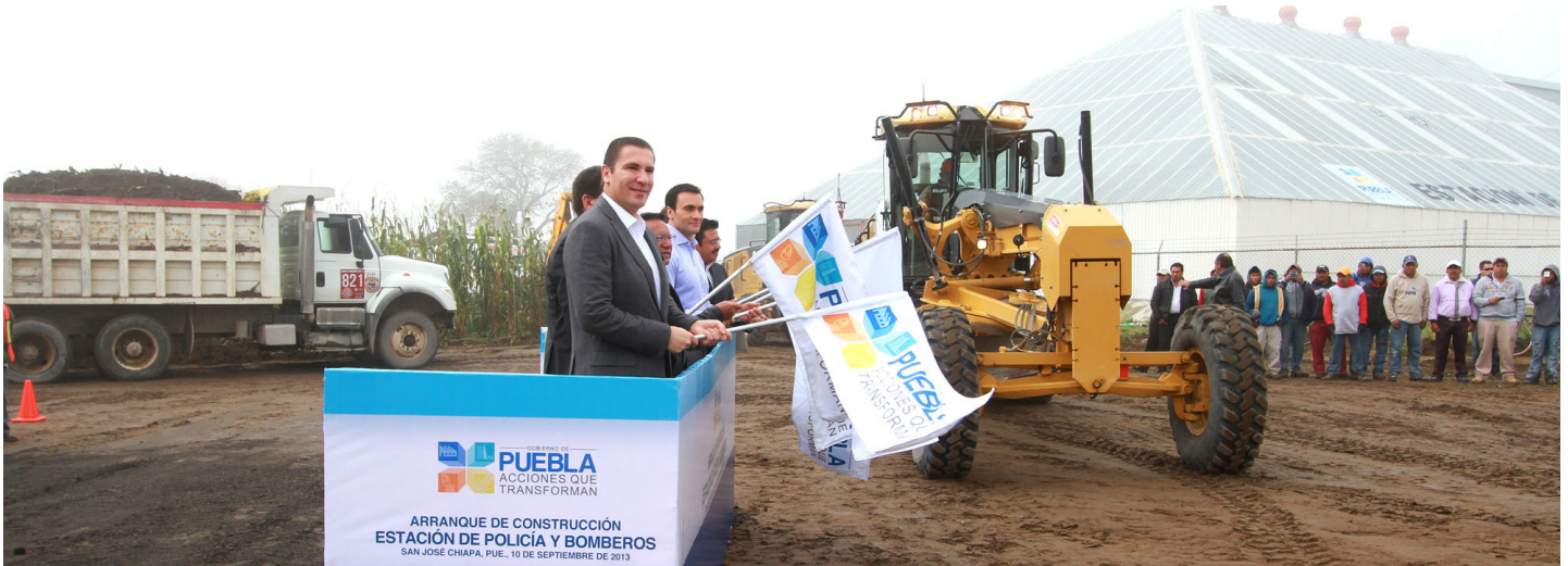
Puesta en marcha de la construcción de la estación de bomberos y policía en el Municipio de San José Chiapa
