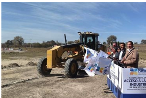
Puesta en marcha de la Autopista de acceso a la Zona Industrial de San José Chiapa
