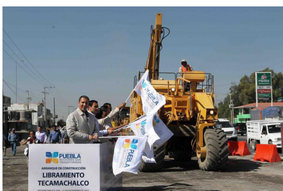
Puesta en marcha del Libramiento carretero de Tecamachalco
